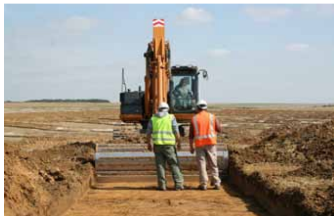
Vue d'un diagnostic en cours à Etrécourt-Manancourt
