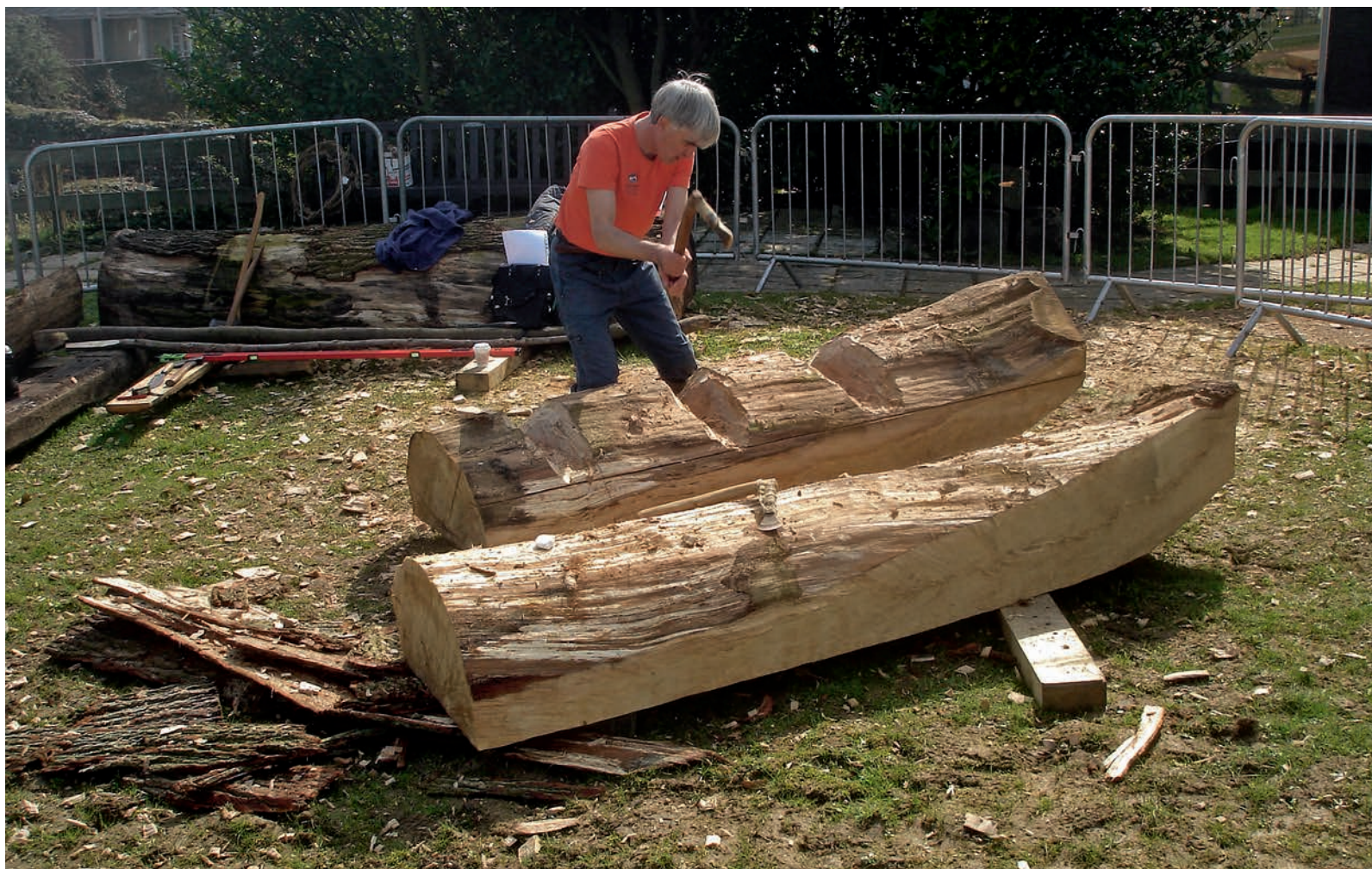
Fig. 37. Travail de dégrossissage du bois lors de la construction de la réplique 1/2 en 2012
