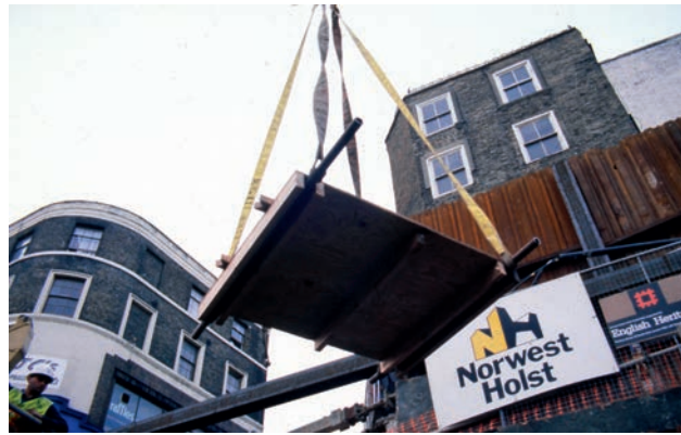
Fig. 25. Vue de l'extraction à la grue d'une des parties découpées à la scie
