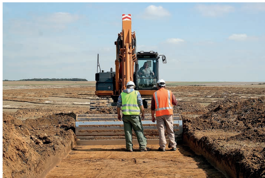
Fig. 47. Vue d'un diagnostic en cours sur le bassin du Tarteron, à Étricourt-Manacourt (Somme, France)
