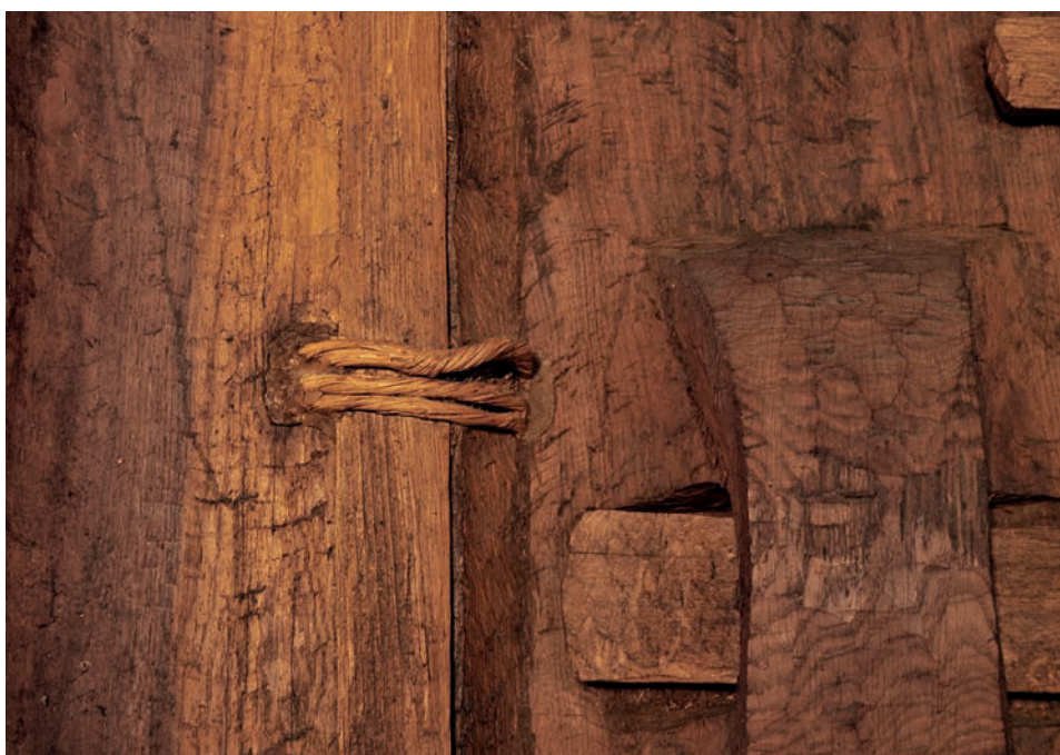
Fig. 38. Détail d'un taquet de l'une des planches du fond
